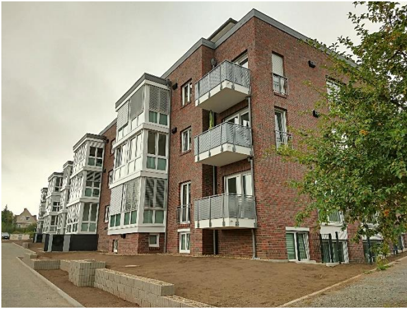
fertiggestelltes Gebäude Jacobsgarten, 1. BA, Stand 30.08.2022 Westseite Foto: ipb
