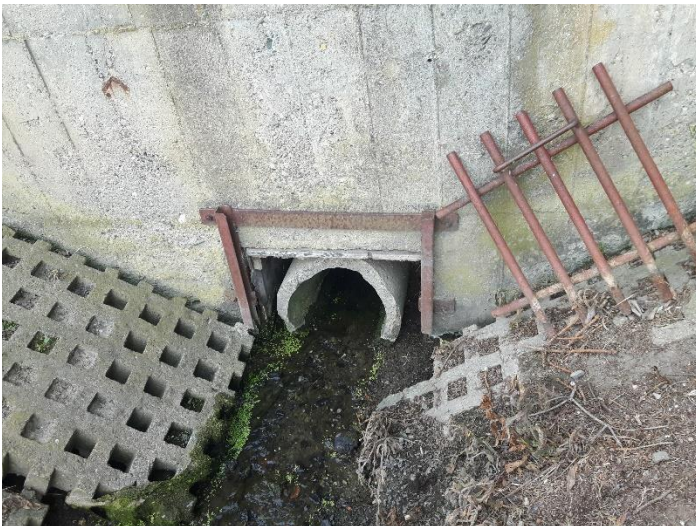
Übergang des nördlichen Entwässerungsgrabens in einen verrohrten Abschnitt bis zum Anschlusspunkt in der Wassertorstraße Foto: ipb
