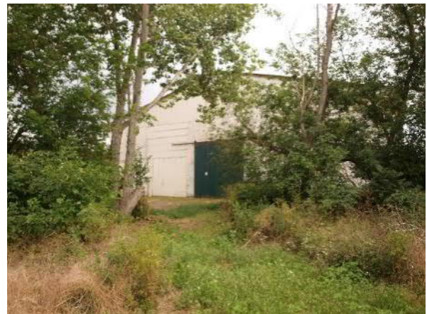
Lagerhalle und randliche Eingrünung (Blick nach Süden)
