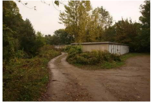
Garagenhöfe mit angrenzendem Gehölzbestand (Blick nach Osten)
