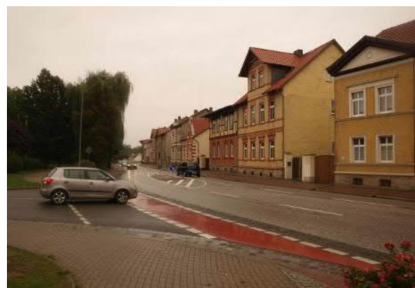
Teilfläche mit Wohnbebauung (Blick nach Südosten)
