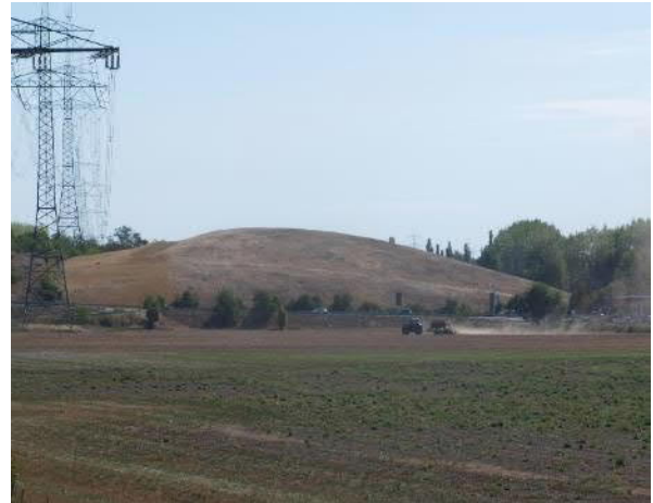
Die Teilfläche 1.2 a liegt auf der Deponie im Hintergrund, rechts von der Freileitung (Blick nach Osten)
