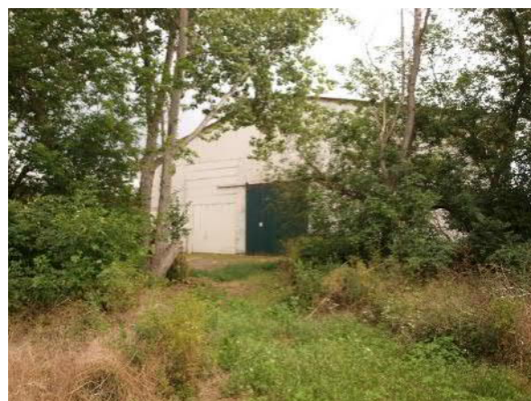
Lagerhalle und randliche Eingrünung (Blick nach Süden)
