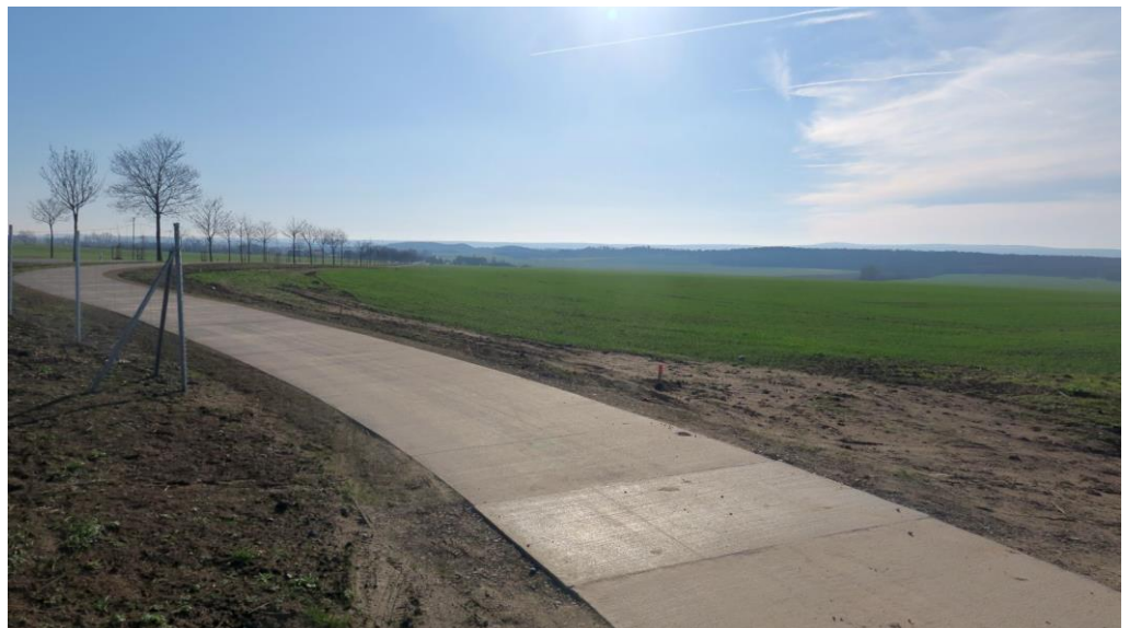
Fotostandort 4: Blick vom neu gebauten Radweg nördlich von Münchenhof nach Süden
