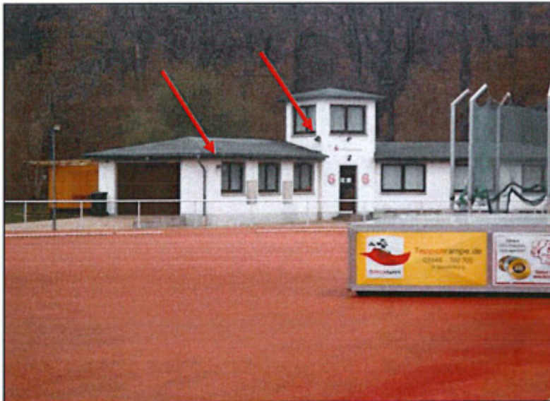
Bild 6: Zeigt das Stadiongebäude im Bereich der leichtathletischen Anlagen für Wurf- und Hochsprungdisziplinen. Hier sind am Turm und am angrenzenden Gebäude Lautsprecher für den Stadionsprecher installiert.
