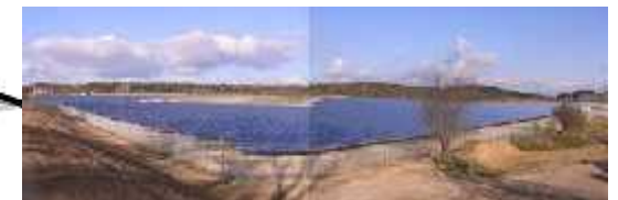
PV-Park Modular erweiterbar
