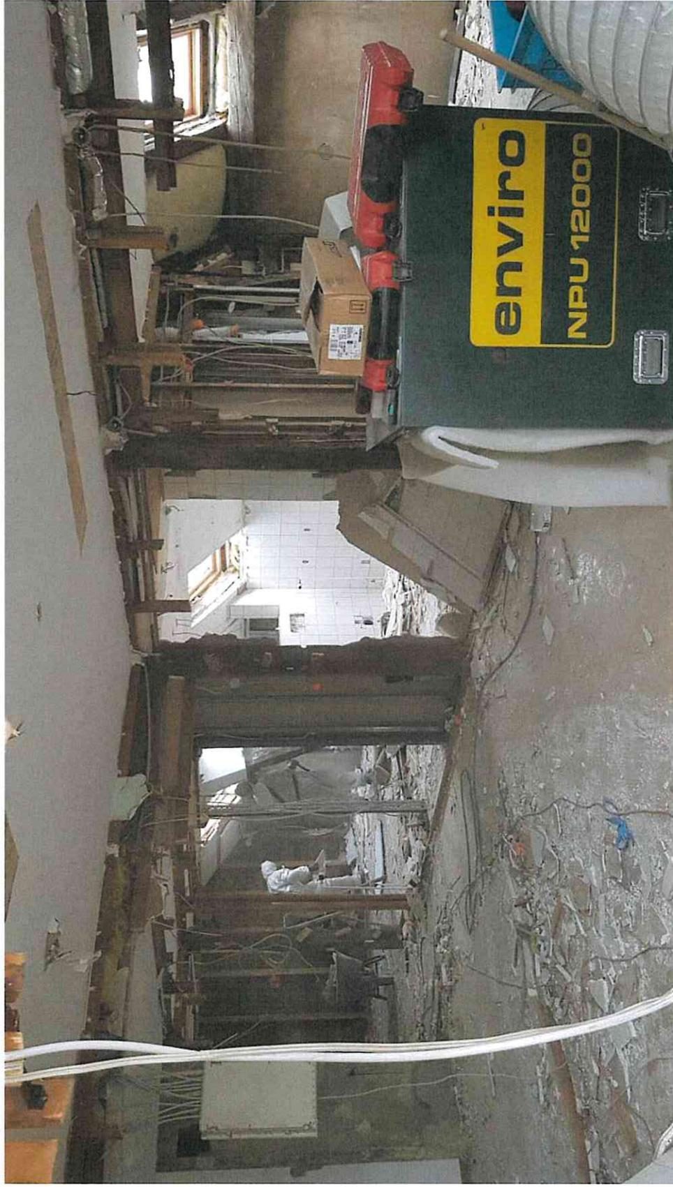
DG Umbaubereich während der Entkernung im Unterdruckverfahren unter Einhaltung besonderer Arbeitsschutz- und Umweltschutzmaßnahmen
