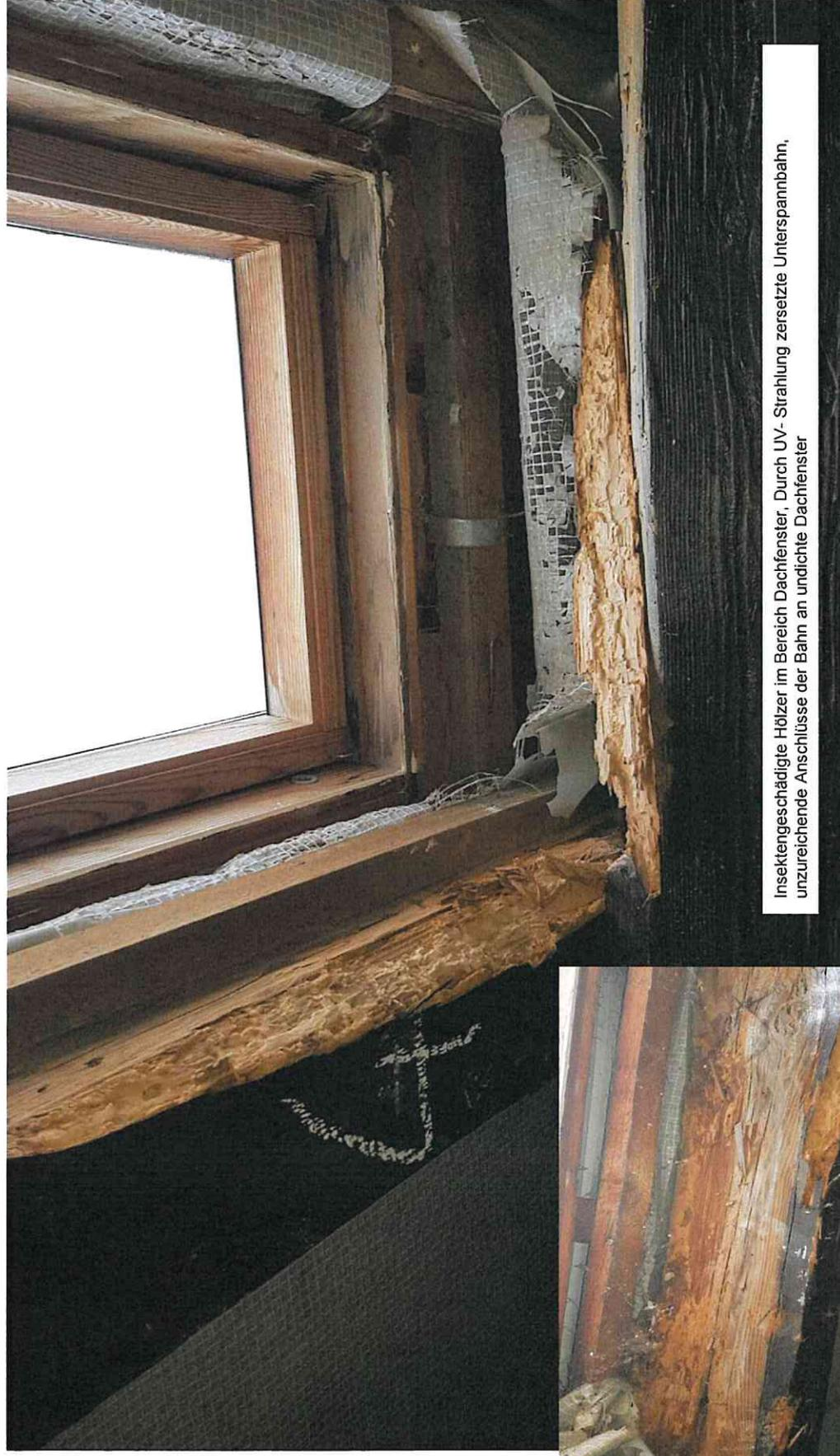
Insektengeschädigte Hölzer im Bereich Dachfenster, Durch UV-Strahlung zersetzte Unterspannbahn, unzureichende Anschlüsse der Bahn an undichte Dachfenster
