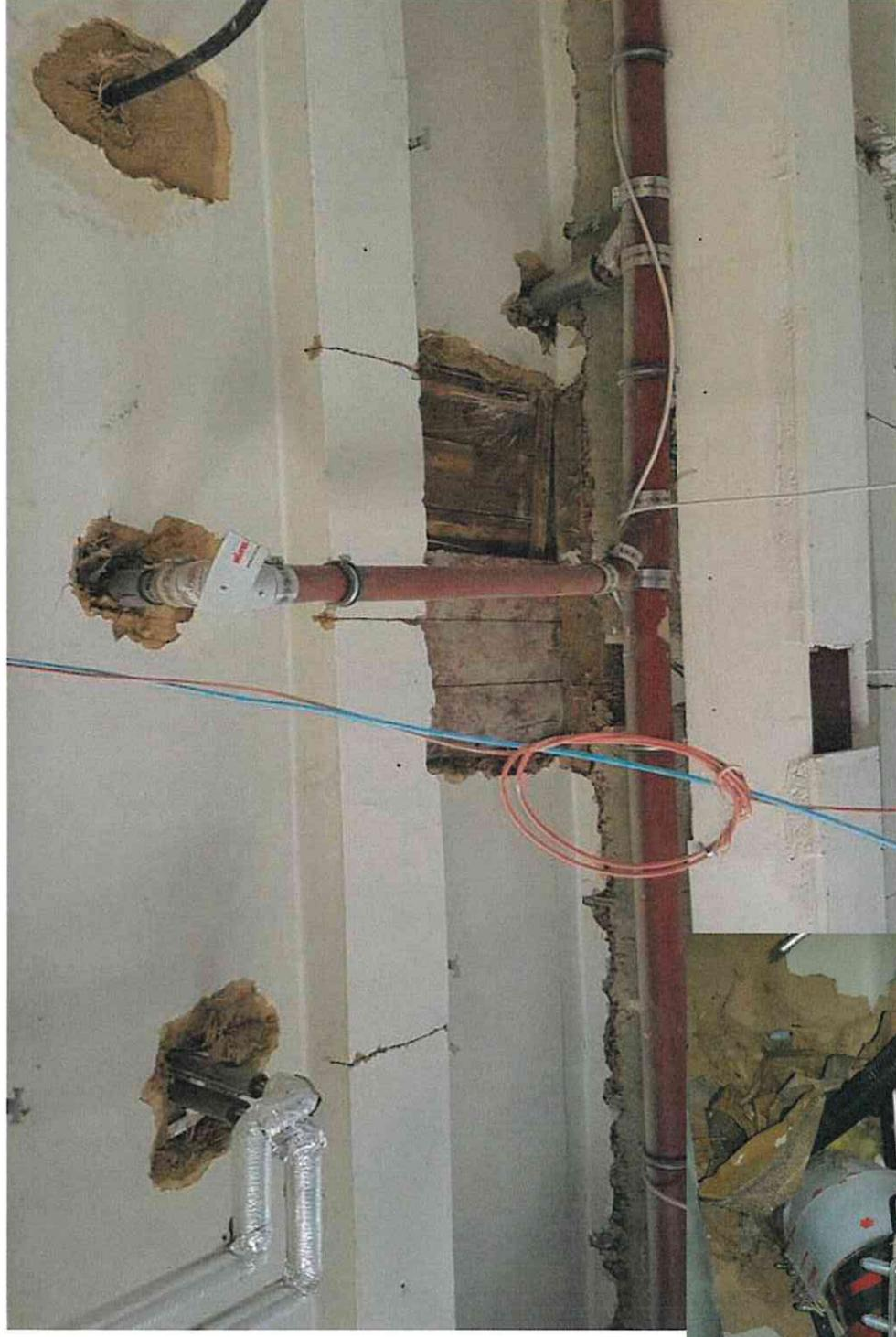
Abwasserleitungen durch die Decke nach oben geführt, nicht sachgemäß geschottet, mit Papier verstopft
