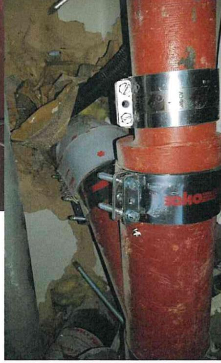
Großflächige Löcher in der Decke mit Brettern, teilweise Teilen von Türblättern „geschlossen“, Löcher mit Styropor verstopft
