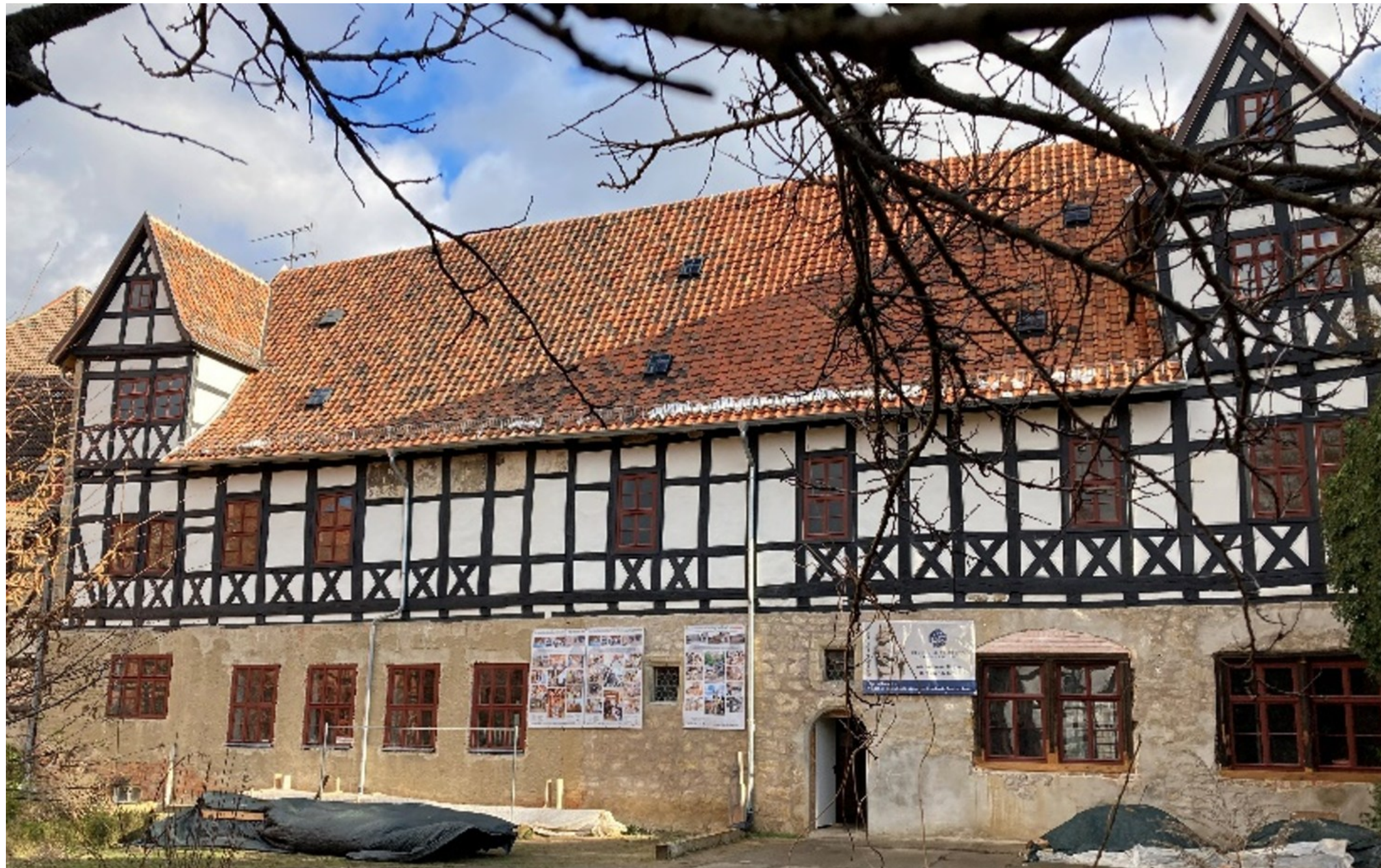
Westfassade aus bauzeitlicher Substanz der Renaissance
